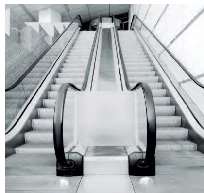
Ограждение ограничивающее доступ
